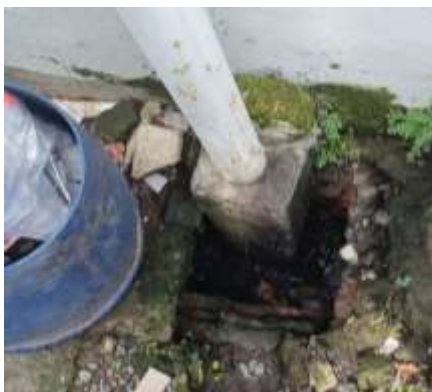
Gambar 2. Kondisi Saluran Pembuangan di Sekitar Lokasi Sampling
