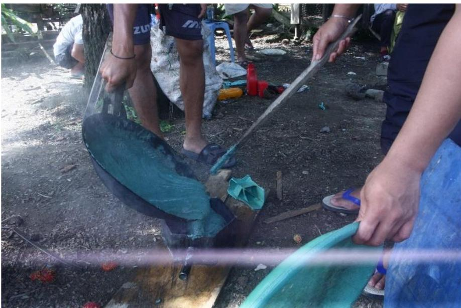
**Gambar 2.** Proses pencampuran dan pemindahan plastik cair untuk pembuatan paving block.
