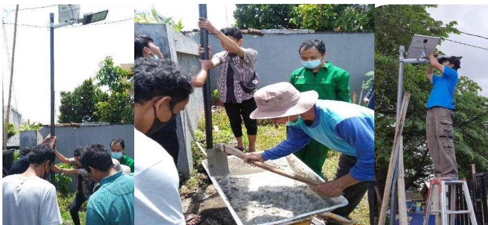
Gambar 5. Pemasangan penerangan lampu jalan umum bertenaga surya sekitar komplek Muhammadiyah Islamic Center.
