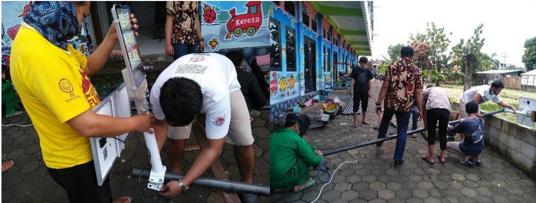
Gambar 4. Pelatihan perakitan instalasi penerangan jalan umum menggunakan panel surya.
